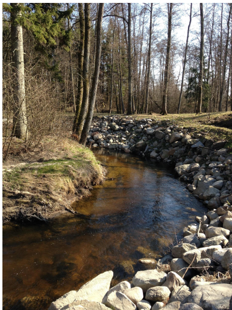
Erosjonssikring av bekkekant ved steinsetting. Foto: Johanne Dolven.
