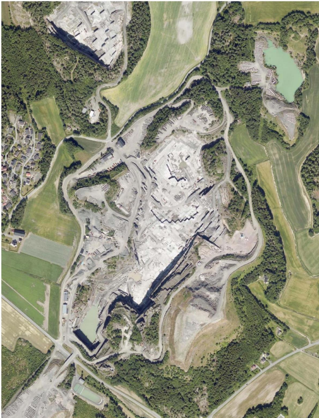
Ortofoto som viser eksisterende situasjon i Klåstadbruddet
