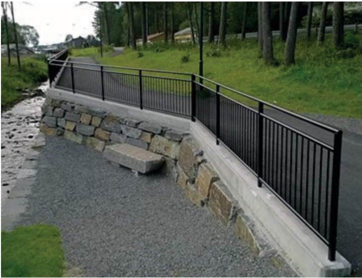
Forstøtningsmur med gjerde
