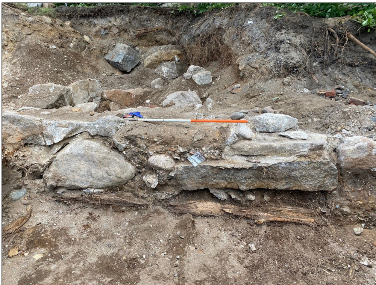
Figur 30. Foto som viser sørenden av grunnmur 1 med tømmerstokkene under. Den rød-hvite stangen er 1 meter lang. Lengst til venstre i bildet er det så vidt synlig en tømmerstokk som ligger vinkelrett på muren. Foto: Trude Aga Brun, VTFK.
