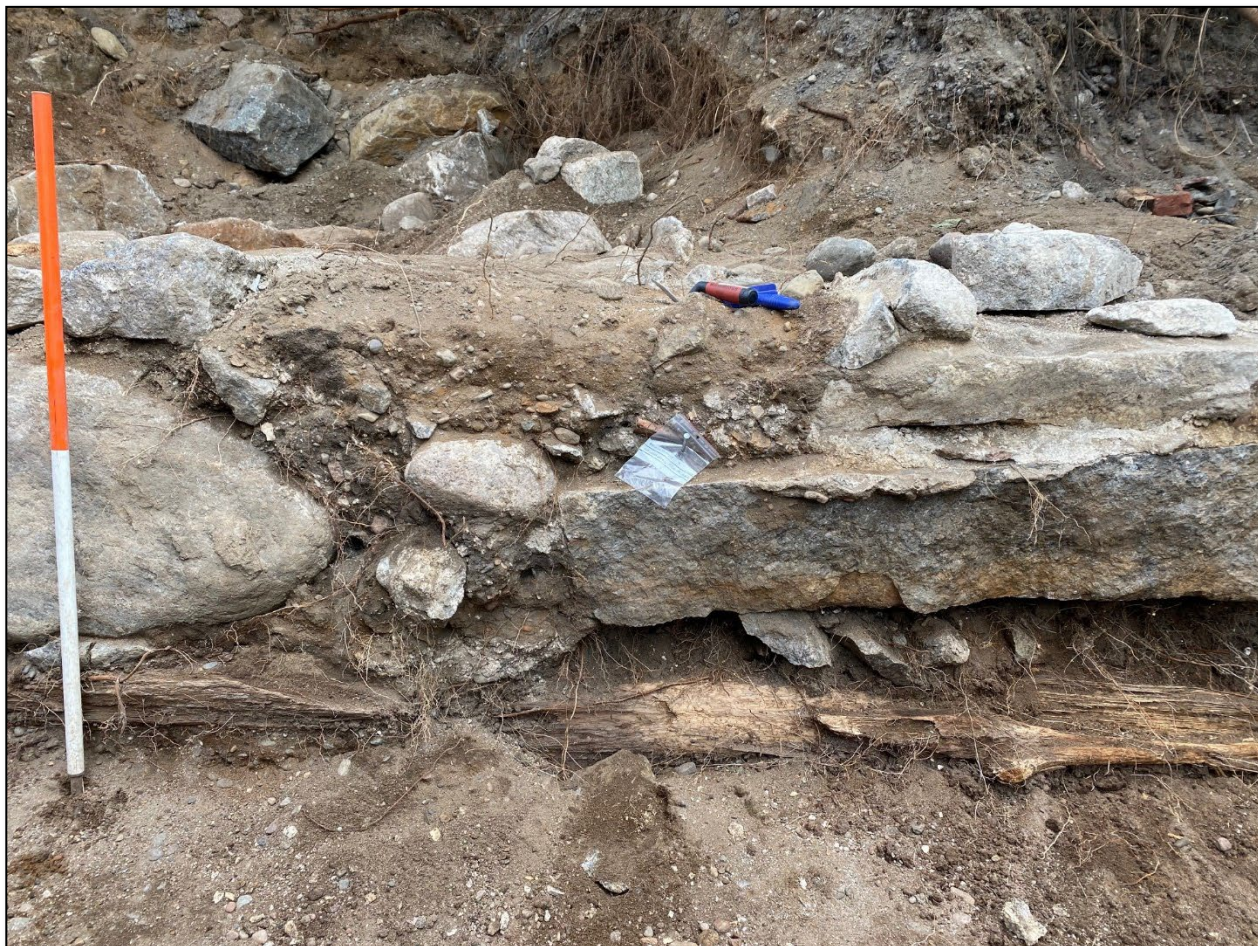
Figur 18. Grunnmur 1 i sørenden. Den rød-hvite målestangen er 1 meter lang. Foto mot øst. Fotograf: Trude Aga Brun, VTFK.
