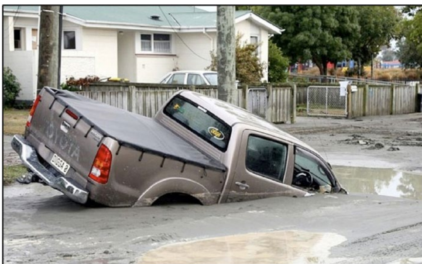
Figur 42 – Bildet viser hvordan det så ut i Christchurch, New Zealand etter Canterbury-jordskjelvene i 2010/2011. Den sandholdige jorden ble utsatt for kraftige rystelser under skjelvene, og resultatet var likvifaksjon. Pga. likvifaksjon som følge av jordskjelvene ble mange bygninger ødelagt, og det er estimert 3 milliarder dollar i skade, særlig for den sørlige øyen i New Zealand. 66
