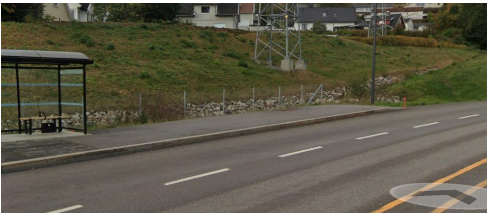
Figur 3: Erosjonssikring langs en bekk sør for planområdet.
