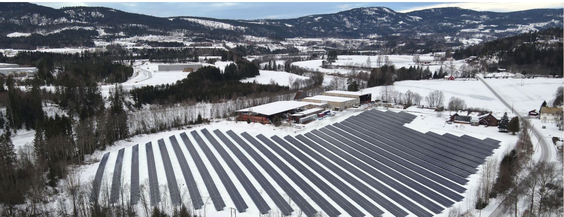
Engene Solkraftverk: 6,1 MWp, 51 mål
