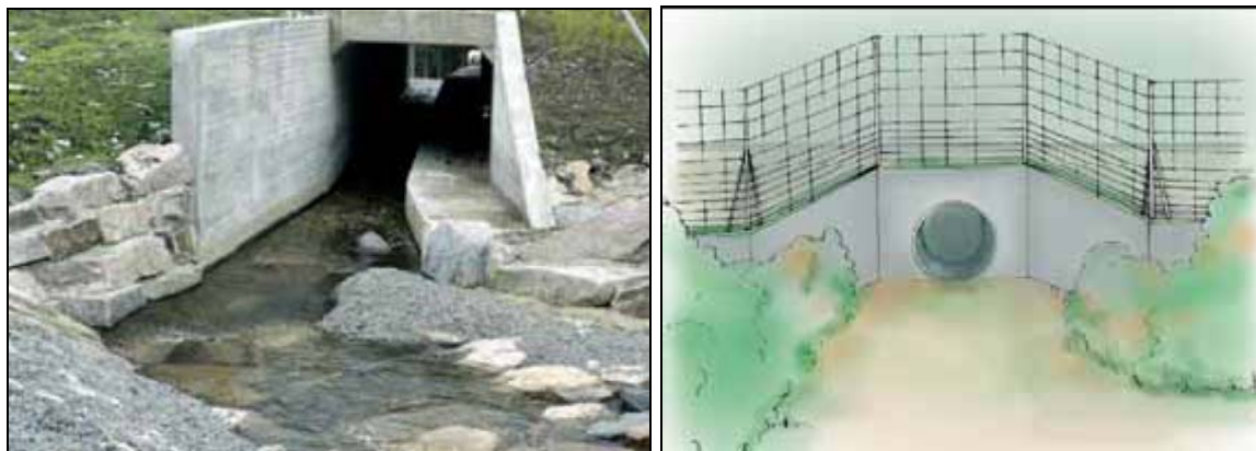
Figur 13: Til venstre eksempel på kulvert for vanngjennomløp som er tilpasset dyrelivet med en "cat-walk". Bildet til høyre viser en prinsippskisse for kulvert for små dyr. Man kan lage ledeanordninger som leder dyrene mot kulverten, slik at man unngår at de krysser vegen på andre steder. Bildene er hentet fra Statens Vegvesens håndbok 242.
