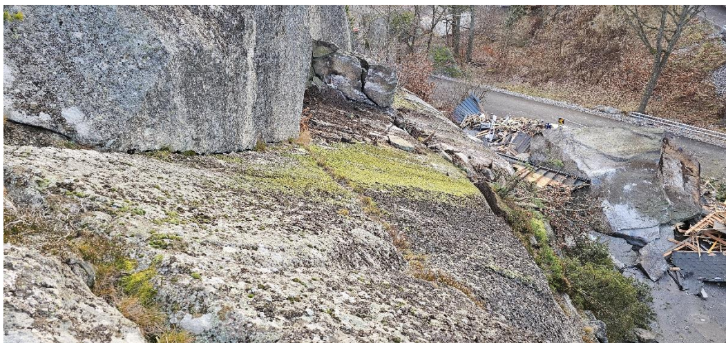
Bilde 1: Bilde fra oversiden av rasområdet. Til høyre i bildet ses nedrast blokk. Sentralt i bildet er sprekkeplan med løsneområde
