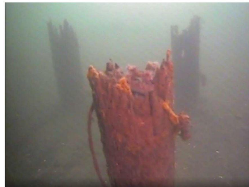
Bilde 2: Pilar, bruddet ved indre del, nord-vestre hjørne
