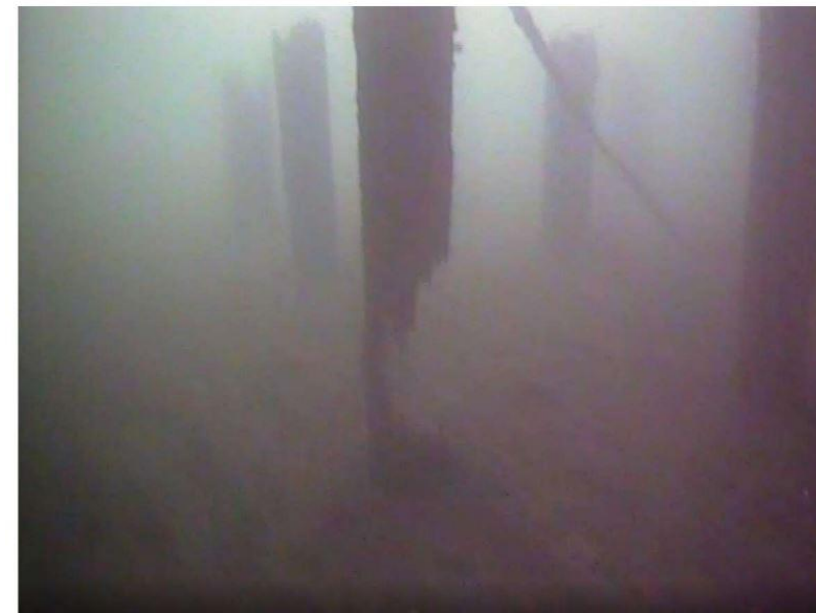
Bilde 2: Pilar, bruddet ved indre del, nord-vestre hjørne
