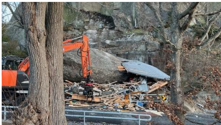
FIGUR 23: BLOKKFALL FRA SIGNALEN I STAVERN, 2024 (KILDE: LARVIK KOMMUNE)
