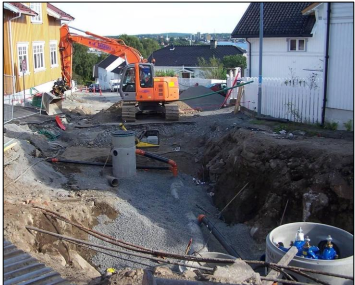
Figur 3 Kabler og ledninger skal samordnes når det graves
