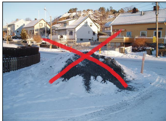
Figur 12 U hensiktsmessig plassering av masser
