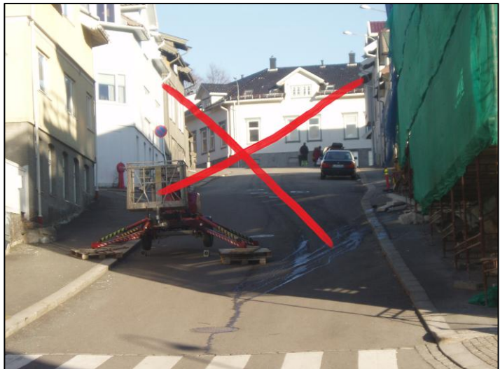
Figur 5 U hensiktsmessig plassering av utsyr
