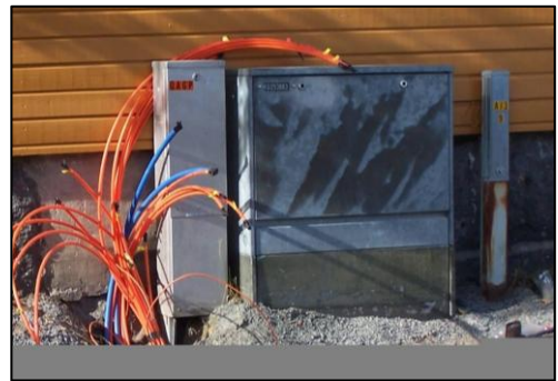
Figur 18 Plassering av skap
