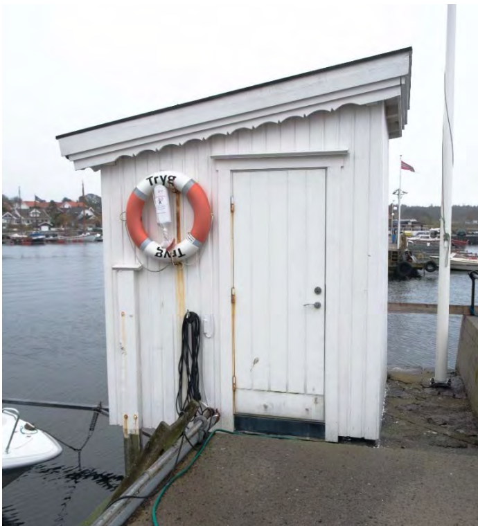
Figur 4-72: Målestasjonen på Helgeroa ytterst (på innsiden) av vestre molo, se Figur 4-73.
