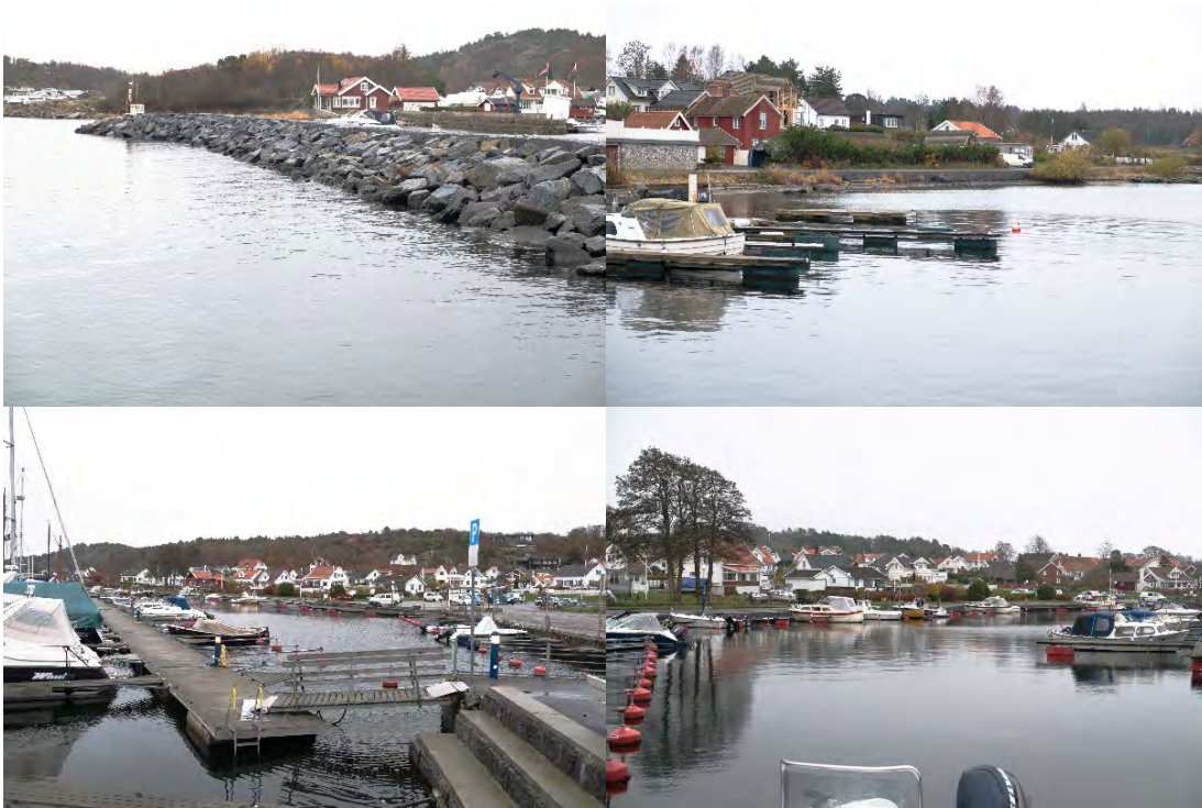
Figur 4-71: Bilder fra befaringen ved Helgeroa.
