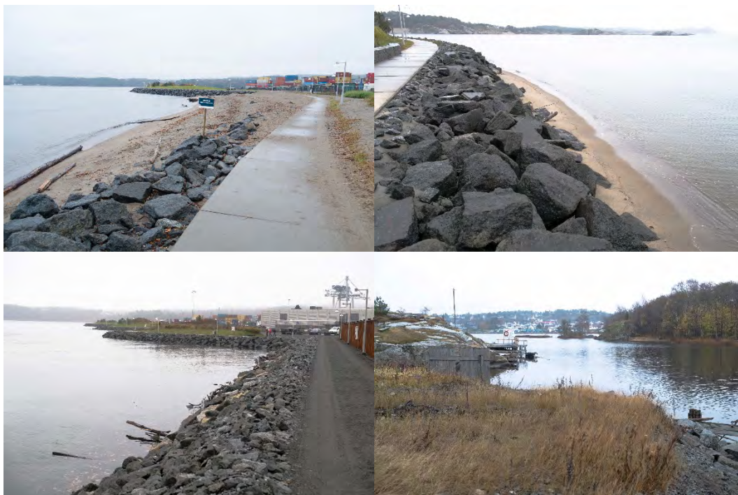
Figur 4-84: Bilder fra befaringen ved Revet og utløpet av Numedalslågen.
