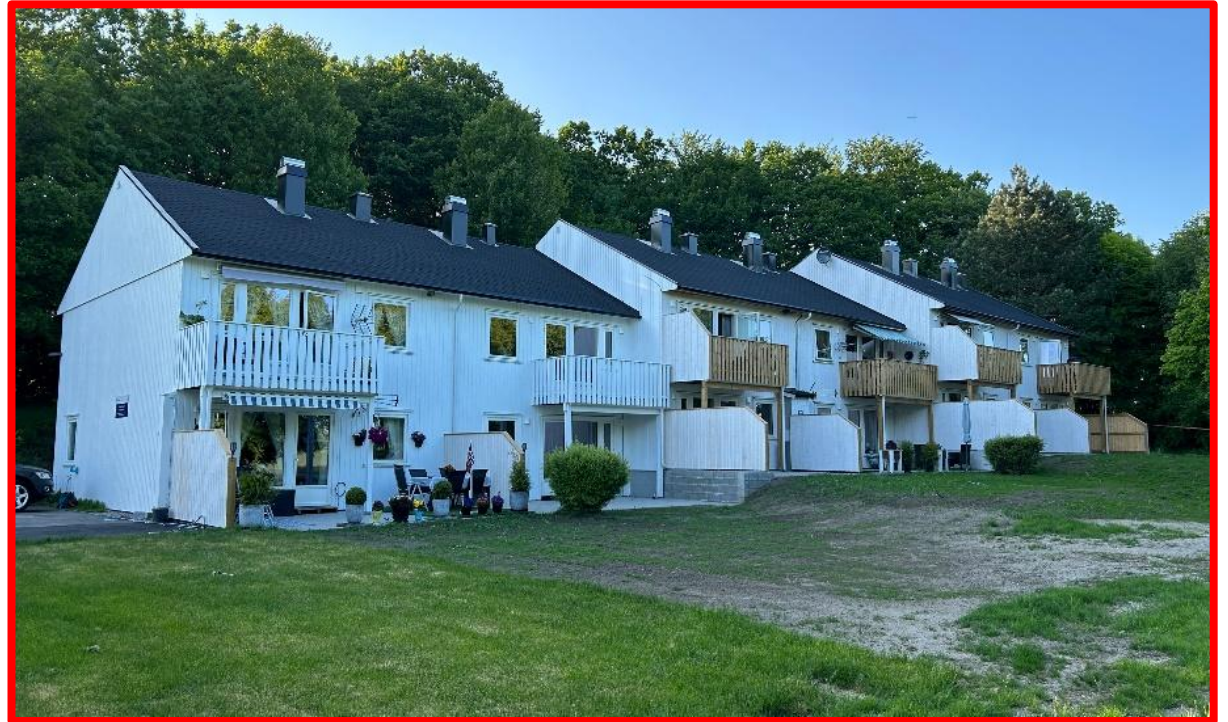
Iver Hesselbergs vei v/Gloppesenteret. Rehabilitert 2023-2024 med nye tak, nye balkonger samt oppussing av fasader
