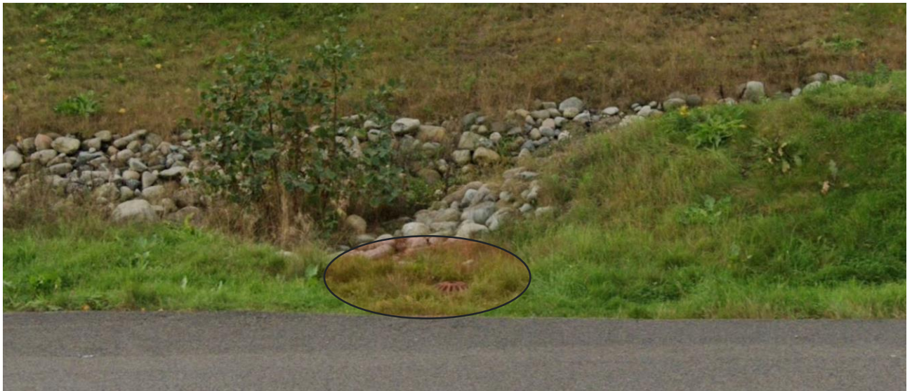
Figur 8 Bilde hentet fra Google Streetview. Bildet er tatt i 2022. Rist er markert med sirkel i bildet.
