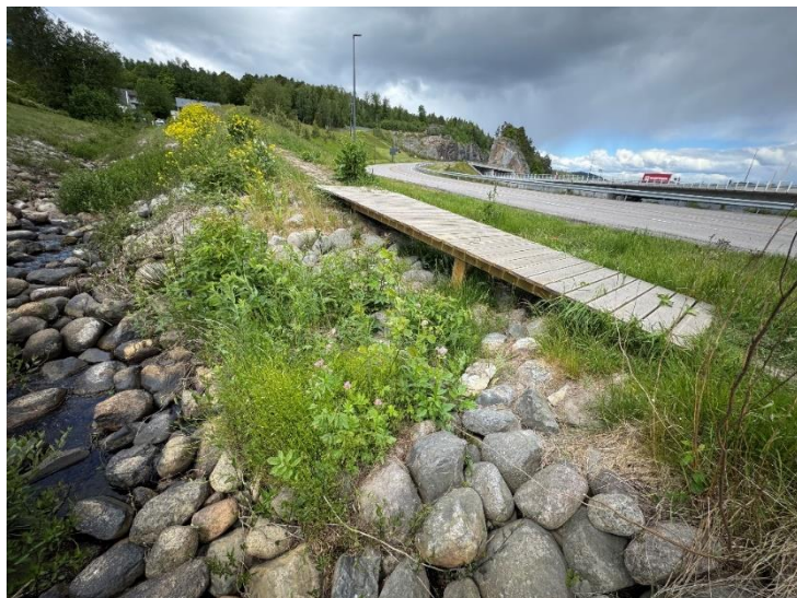
Figur 9 Bilde tatt av Norconsult 16. mai 2025. Trebro er satt opp siden 2022, og det kan se ut som det er lagt på noe mer steiner sammenlignet med bilder fra 2022. Innmålinger viser like terrenghøyder i åpningen i 2022 og 2025.
