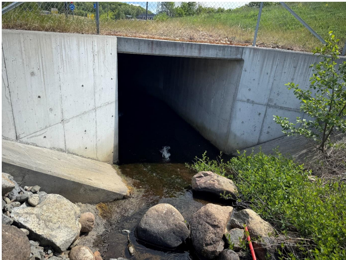
Figur 5 Innløp til kulvert.
