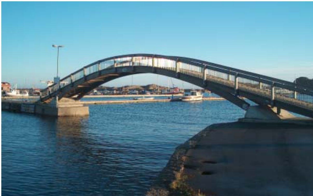
Brua i Stavern båthavn.
