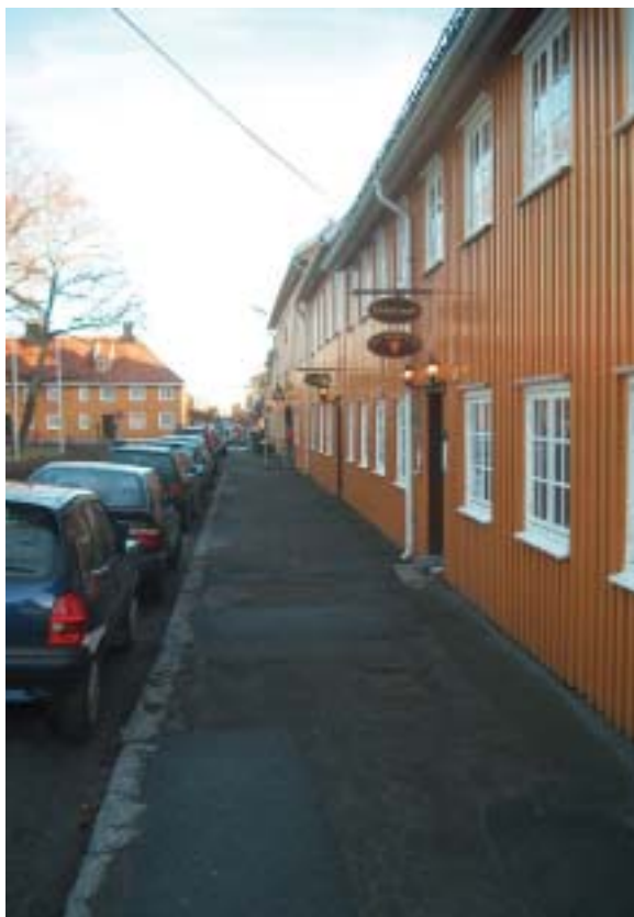
Bildet over viser del av Storgata, ved Pumpeparken.
