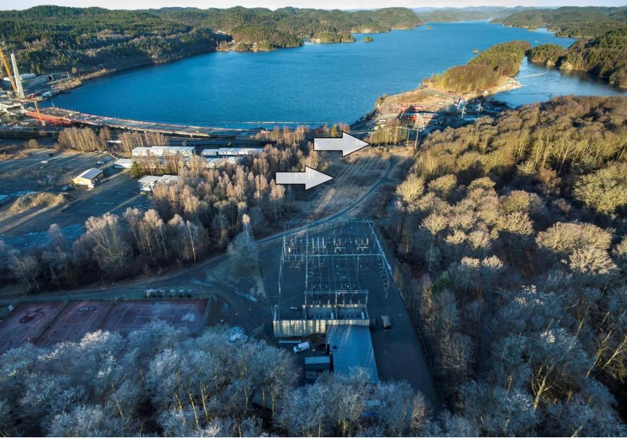
Høyspent på Bergeløkka
