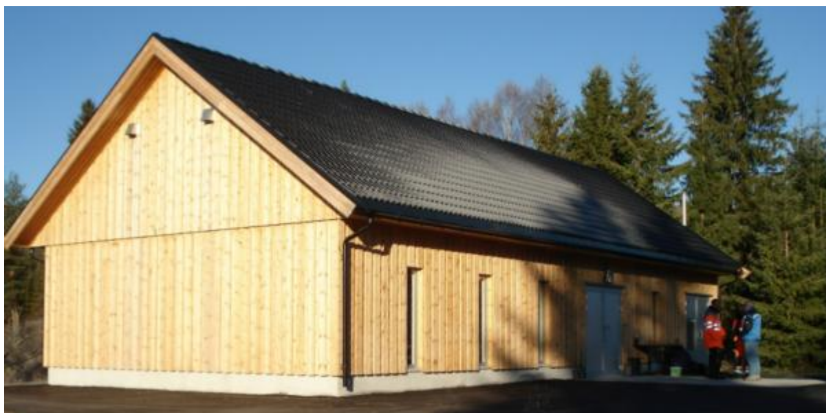
Naugfoss vannverk før åpning i oktober 2010.
