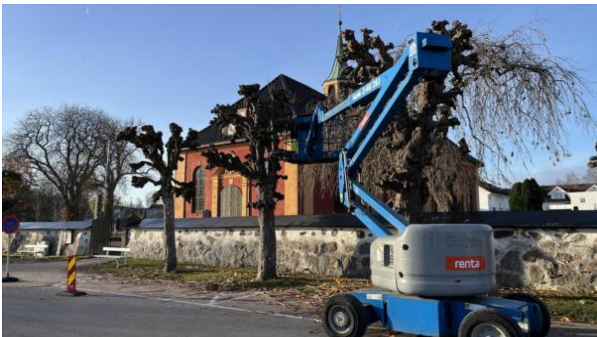
Kolling av gatetrær i Stavern.
