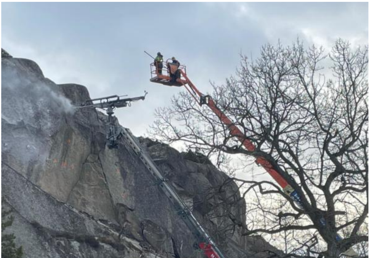
Fjellsikringsarbeid Signalfjellet, Stavern.
