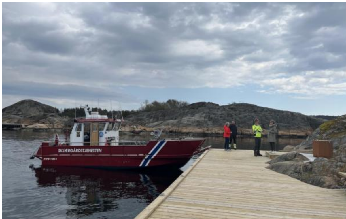
Nyrehabilitert brygge og grillplass på Uleholmen i Viksfjord.
