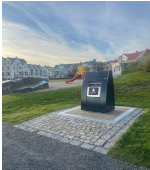
Ny, nedgravd avfallscontainer på Kronprinsen, Stavern.
