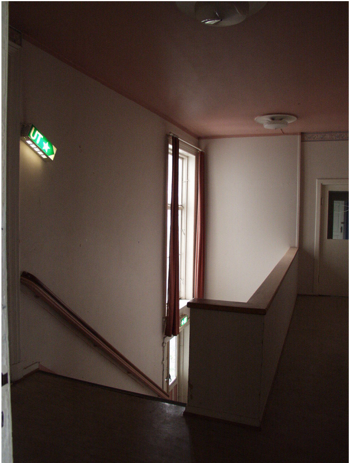
Figur 11. Larvik. "Festiviteten." Rom 201, Hall, 2. etasje. Sett mot syd. Vinduet i full høyde på nordveggen er opprinnelig, men med sekundær vindusgerikt. Foto. JB. 2003.
