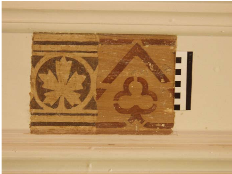
Figur 43. Larvik. "Festiviteten." Rom 202. Avdekket dekor på døroverstykket. Opprinnelig sjablondekor fra periode 1. 1874 til venstre. Sjablondekor fra periode 3. 1890-1900 til høyre. Foto. JB. 2006.
