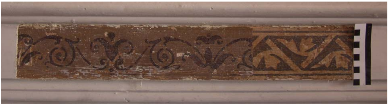
Figur 40. Larvik. "Festiviteten." Rom 202. Avdekket dekor på brystningslista. Opprinnelig sjablondedekor fra periode 1. 1874 til høyre. Sjablondedekor fra periode 3. 1890-1900 til venstre. Foto. JB. 2006.
