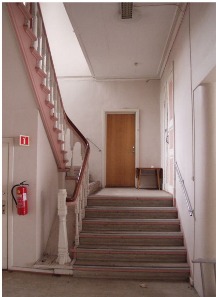
Figur 5. Larvik. "Festiviteten." Rom 102. Trapperommet, nedre del sett mot syd. Den nye "Gabondøra" leder inn til 1700- talls delens 1. etasje. Trappeløp, megler og balustrer er opprinnelige.(1874.) Megleren mangler toppen i mahogni. Foto. JB. 2003.
