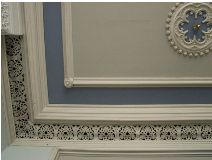
Figur 15. Larvik. "Festiviteten." Rom 202. Salen. Detalj av et hjørne av taket, med et utsnitt av den gjennombrutte gesimsen utført i jernblikk, og takrosetten levert av Brødr, Guidotti i 1874. Foto. JB. 2003.
