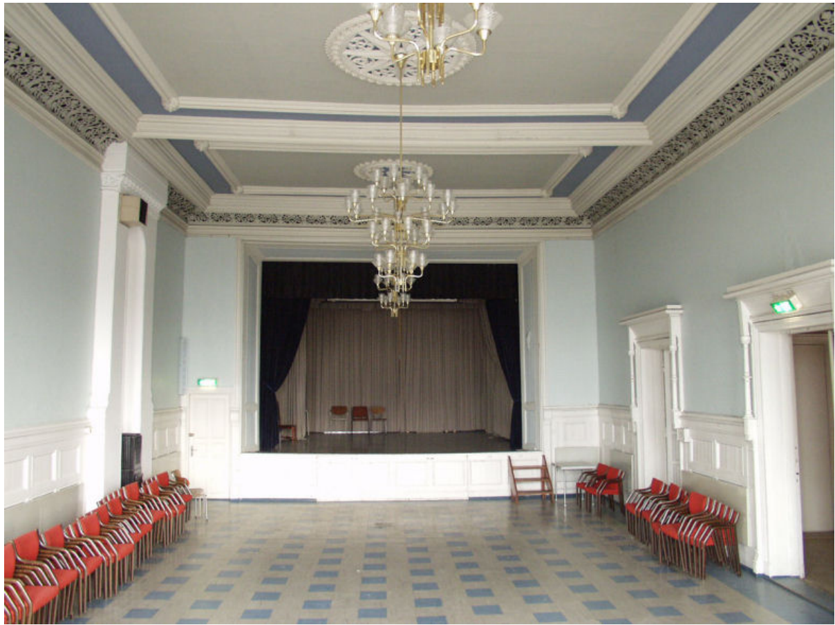
Figur 14. Larvik. "Festiviteten." Rom 202. Salen. Sett mot nord. Legg merke til nedbøyningen av "takbjelkene". Foto. JB. 2003.
