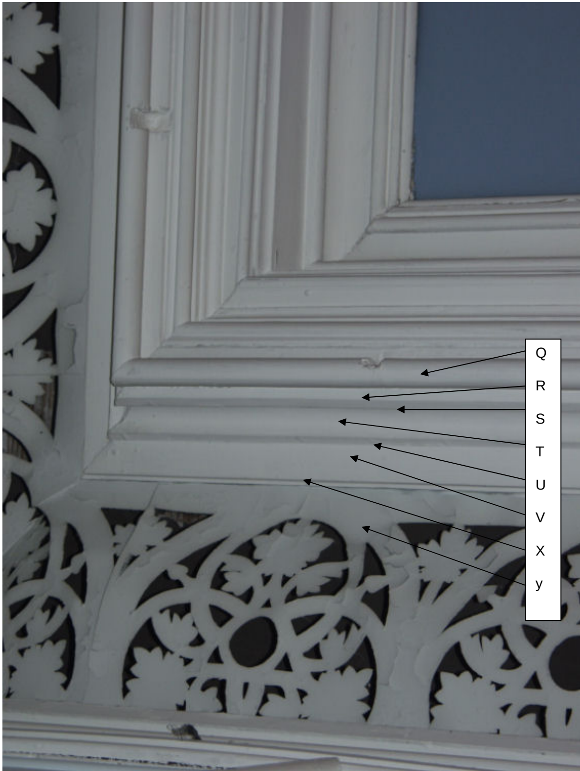
Figur 22. Larvik. "Festiviteten." Rom 202. Gesims mellom ytre takflate og den gjennombrutte jernblikksgesimsen. Nedre del. Bokstavkoder for plassering av farger i periode 1 og 3. Foto. JB. 2005.
