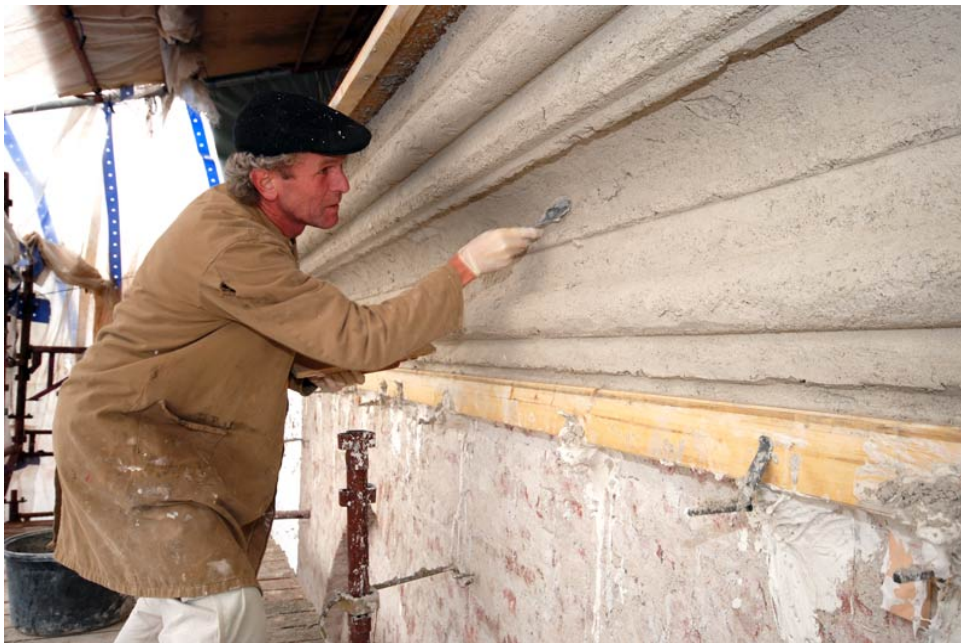
Rekonstruksjon av gesims: Murmester Terje Berner finjusterer på gesims
