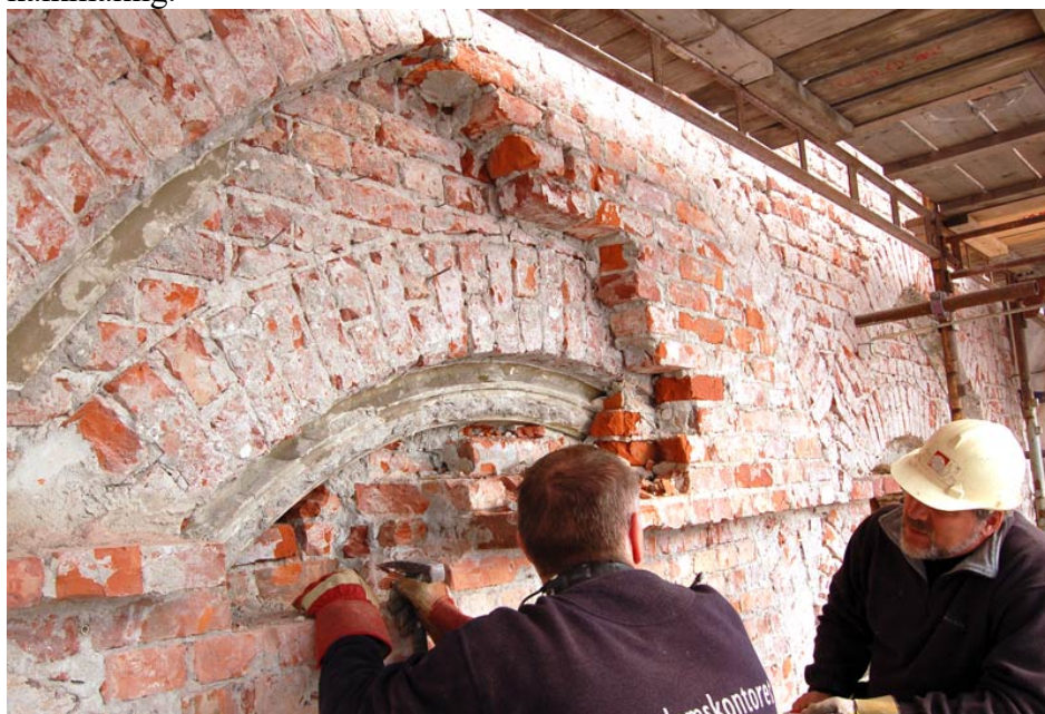
Bygningsarkeologi : Bak forblendingen til vinduene i annen etasje dukket gamle trekninger fram.
