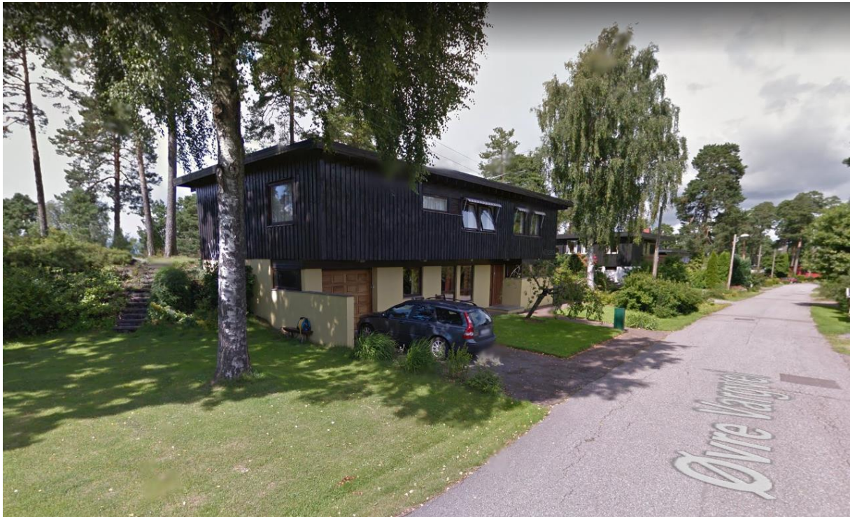
Figur 79: Øvre Vargvei i Husvikåsen. Foto: Google Street View.
