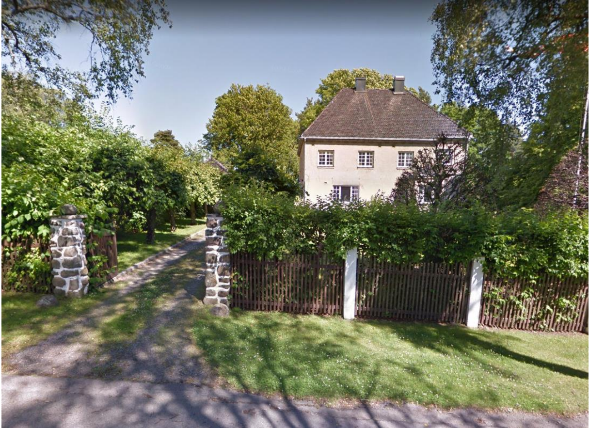
Figur 77: Markveien 5. Foto: Google Street View.
