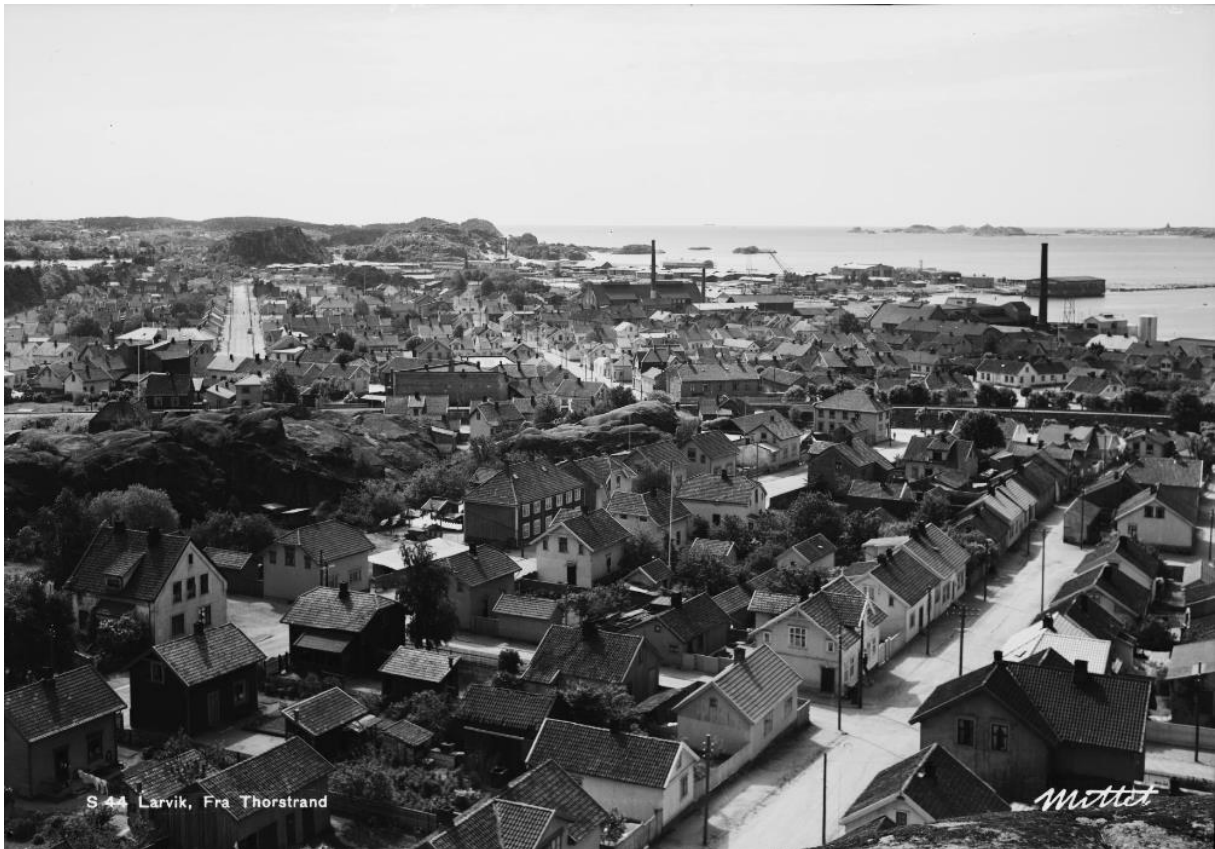
Figur 19: Torstrand i 1945. Foto: Mittet.
