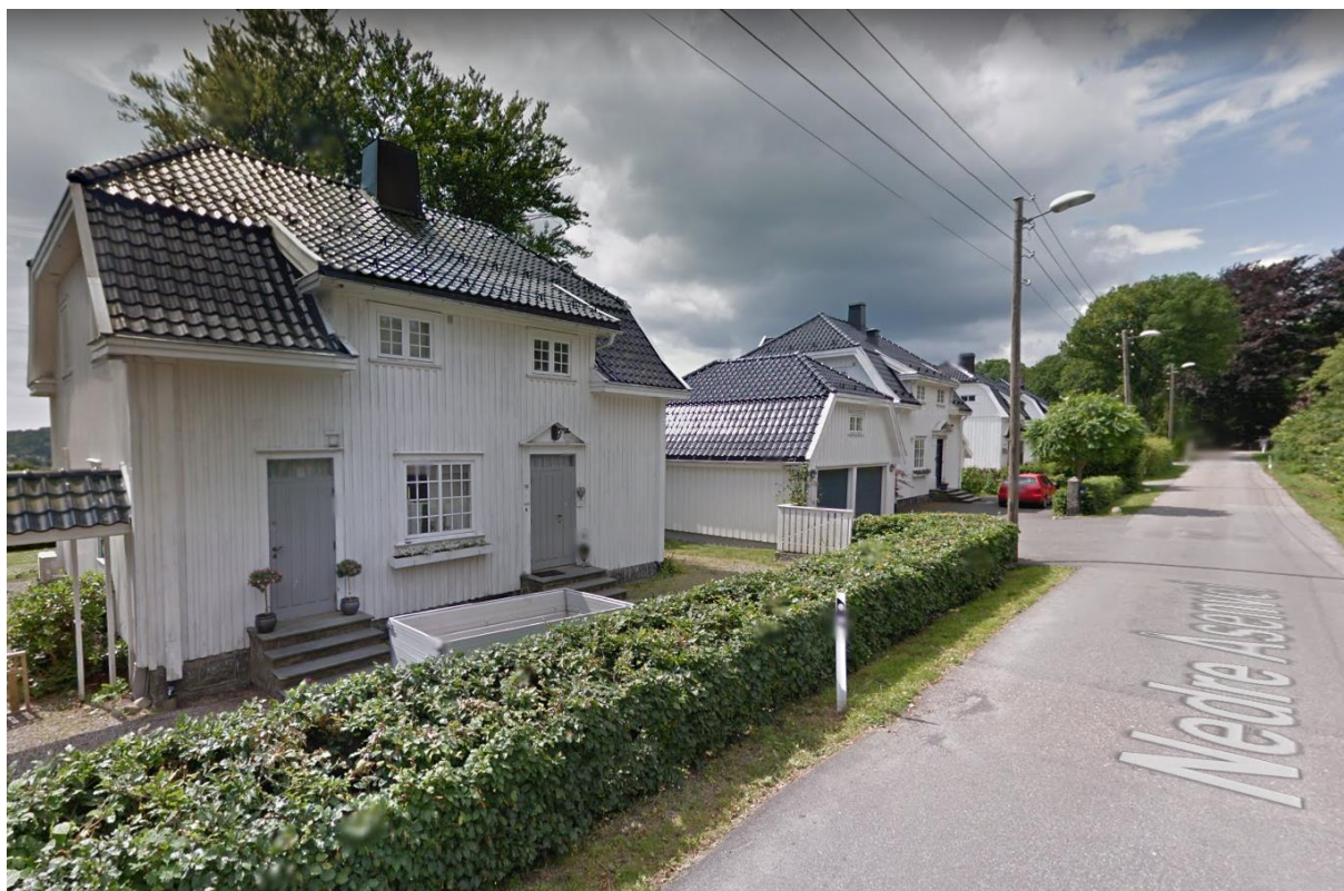
Figur 62: Hvalskytter-villaene langs Nedre Åsen vei. Mansardtak med halv valm, og nyklassisistiske detaljer i fasaden preger husrekken. Foto: Google Street View.
