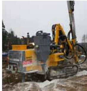
5. Blokkene splittes ved boring
