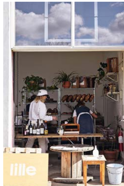
Fasade som kan åpnes og skape forbindelse mellom hagen og bygning
