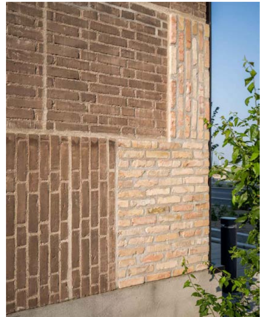
Fasade fra Lendager architects prosjekt Resources Rows. Teglsteinspartier blir skåret ut av bygg som skal rives og ombrukes i nytt bygg
