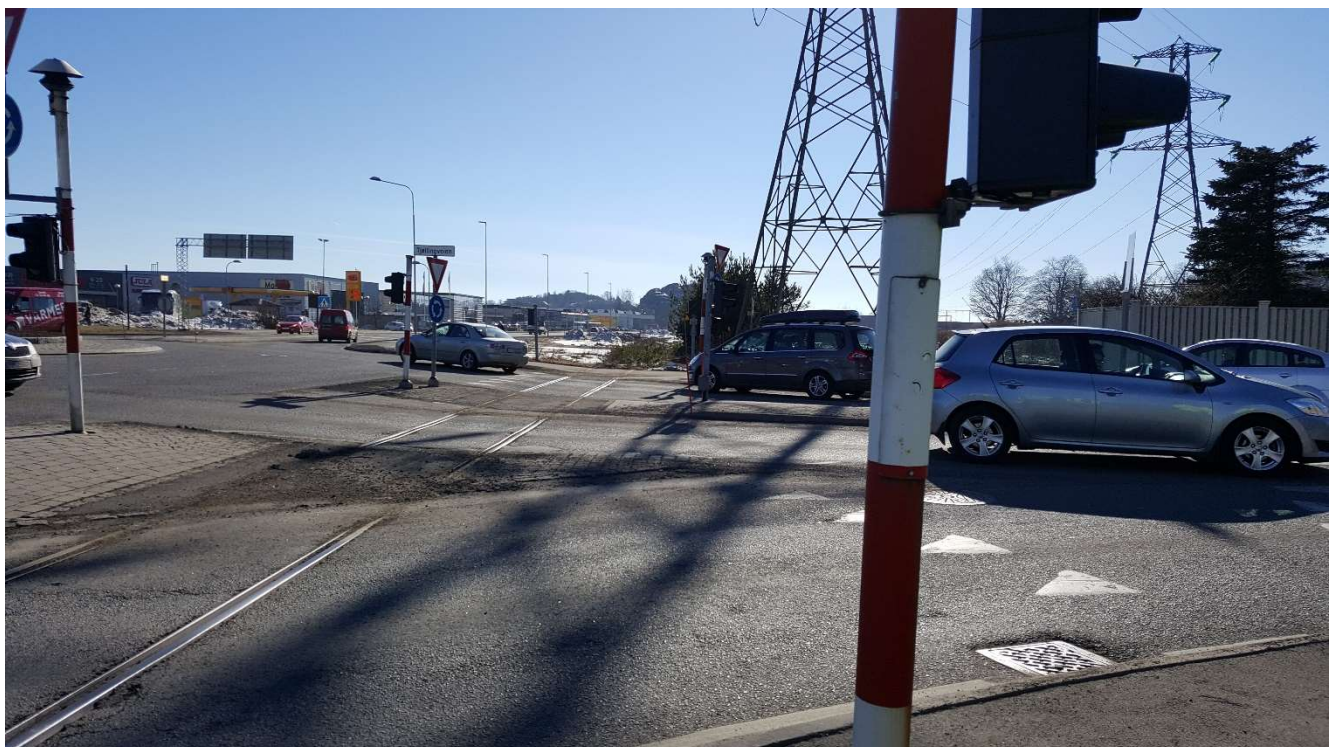
Figur 2-2 viser rundkjøringen i Øyakrysset rv 40/fv 303 og havnesporet som krysser veiarealet
