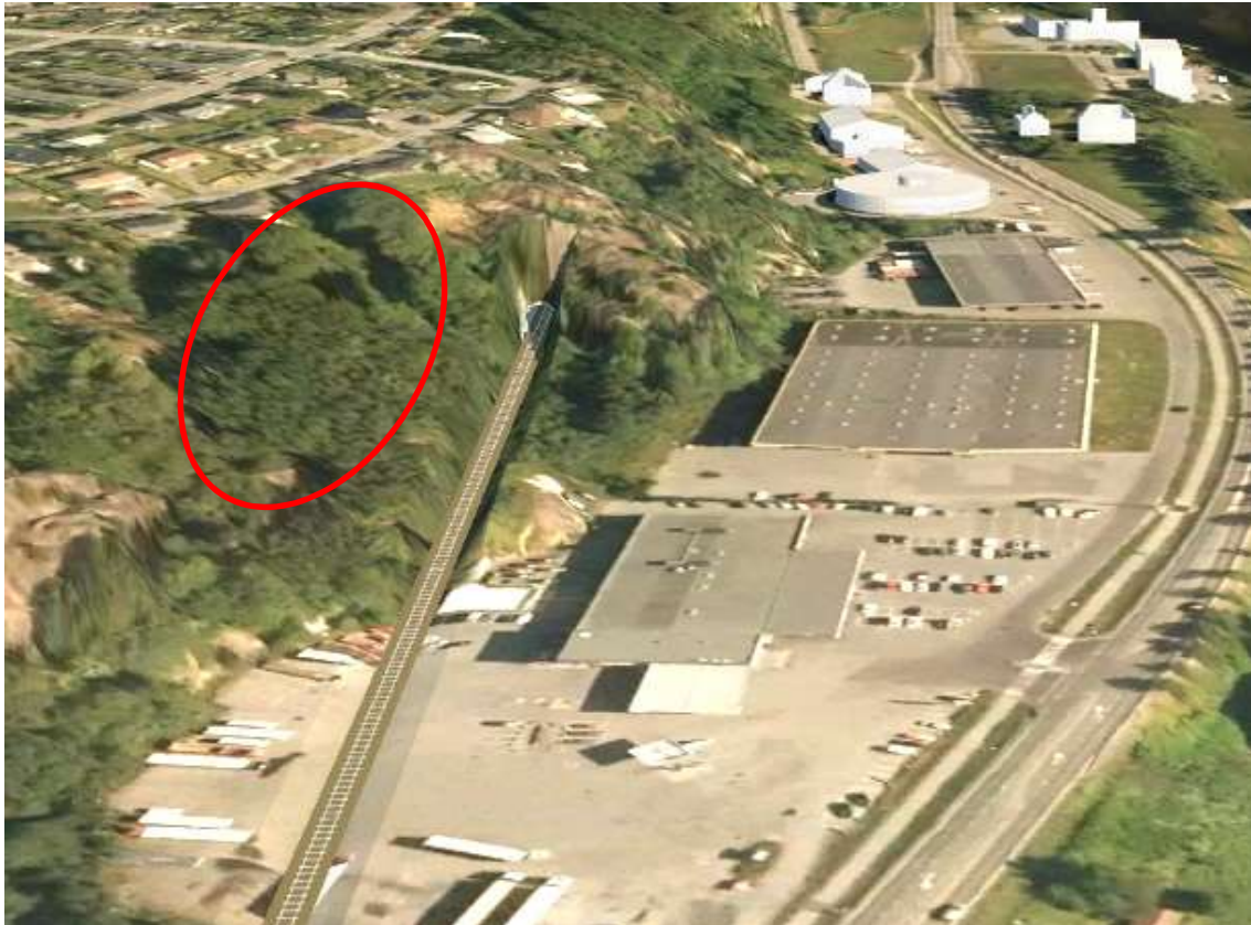
Figur 3-11 Tunnelinnslaget, sett fra sør, i skrenten mellom næringsbebyggelsen langs Elveveien og villabebyggelsen på toppen. Inngrep i vegetasjonen som er avmerket med rødt bør unngås.
