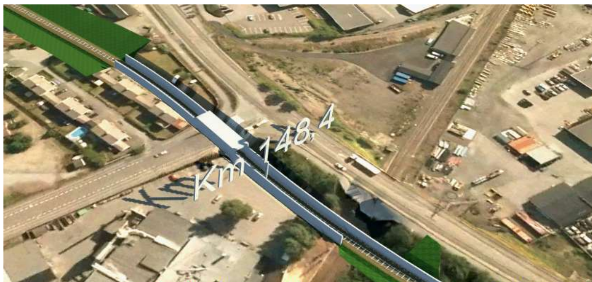
Figur 3-3 Område med kulvert-, tra- og støttemurskonstruksjoner i krysningspunktet med Hoff's gate
