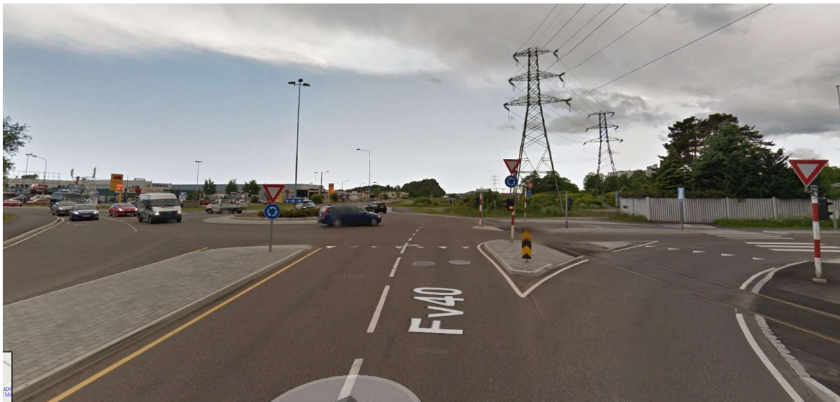
Figur 3-16 Rundkjøring mellom Elveveien (rv. 40) og Storgata der dagens havnespor krysser i plan over veg. Sett mot sør. Bilde fra Google.
