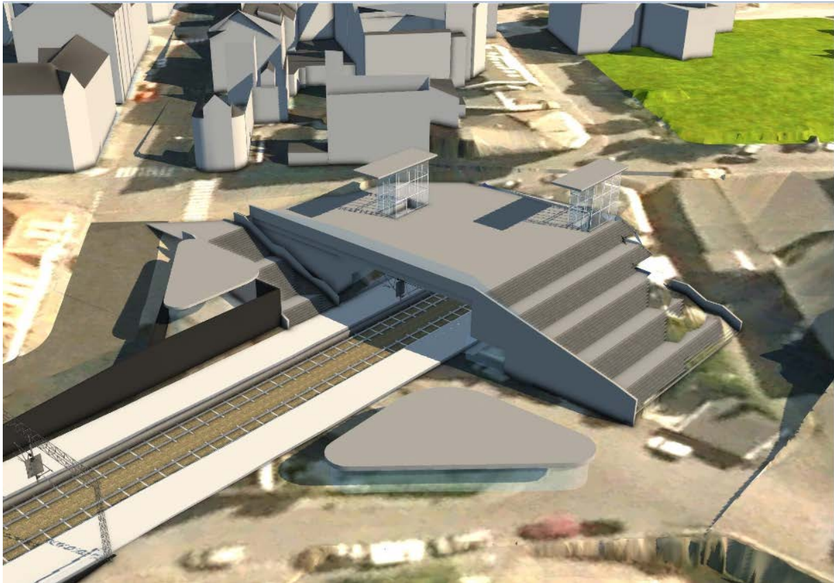
Figur 5-64 Portal over nordre del av plattformområdet. Retning mot Porsgrunn til venstre i bildet.
