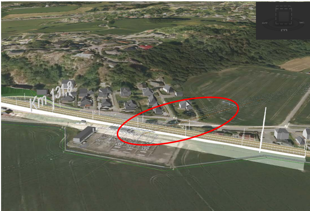
Figur 5-37 Høyspent 132 kV ved Gokstad trafo i Sandefjord. Retning mot Sandefjord til venstre i bildet
