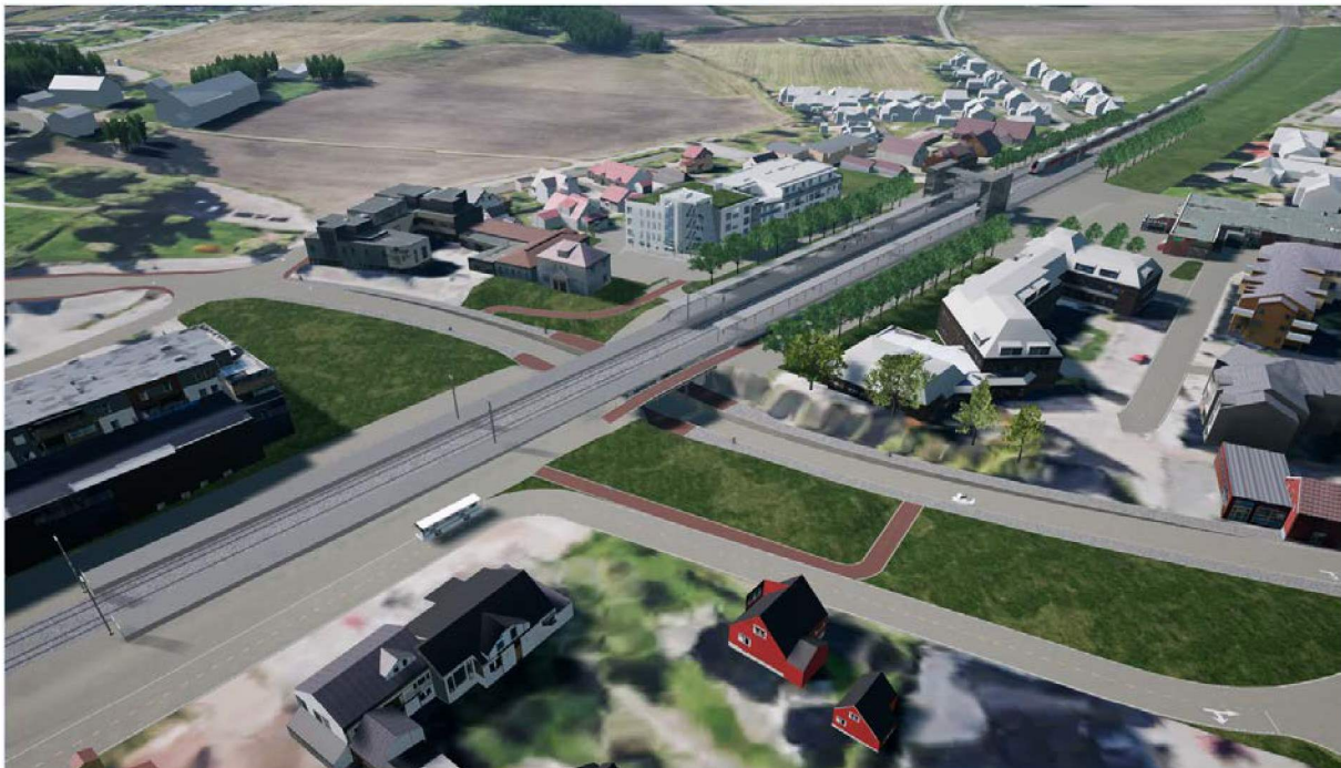
Figur 5-5 Oversikt Stokke med ny stasjon, retning mot Sandefjord til høyre (øverste hjørne)
