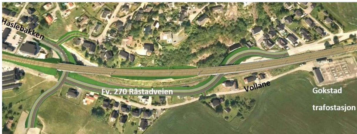
Figur 5-33 Omlegging av fylkesvegen sør for Gokstad trafostasjon og omlegging av Haslebakken. Retning mot Sandefjord til venstre i bildet.
