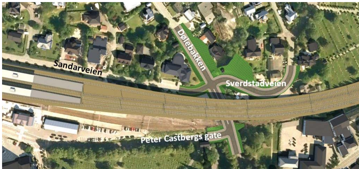
Figur 5-34 Omlegging av Dølebakken med tilhørende kryss. Ny Sandefjord stasjon til venstre i bildet.
