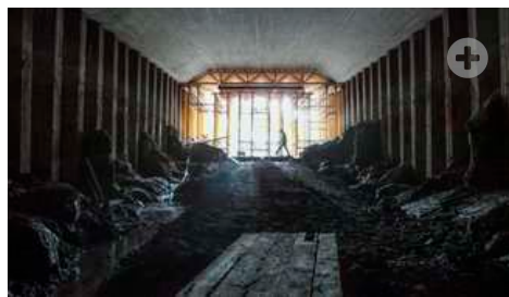
Både gulv, tak og vegger er på plass før fjerning av masser i den nye tunnelen. (Foto: Mari Gisvold)
