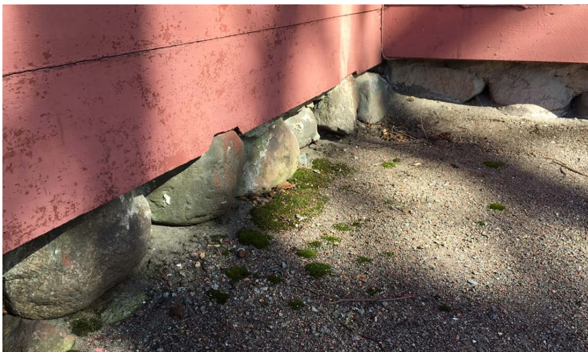
Figur 12-3: Deler av Herregården er fundamentert på rullestein på leire
