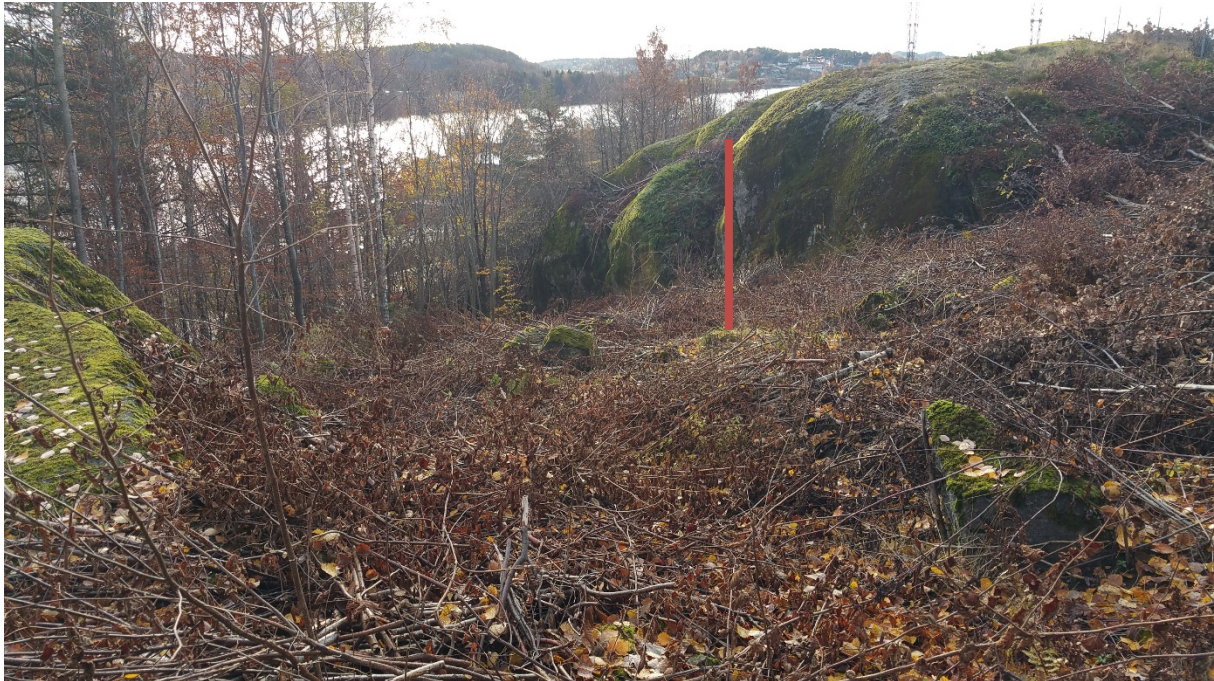
Figur 10-4 Påhuggsområde for tunnel ved Yttersøveien. Bildet er tatt mot sydøst.
