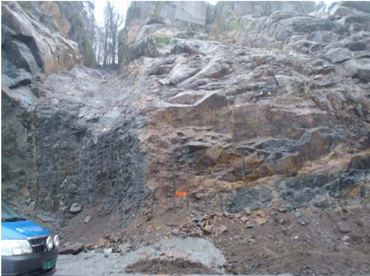
Figur 3-4: Foto viser oppsprukket diabasgang, fra utbygging E18 Sky – Langgangen. Foto er hentet fra Ingeniørgeologisk rapport for byggeplan E18 Bommestad – Sky [11].
