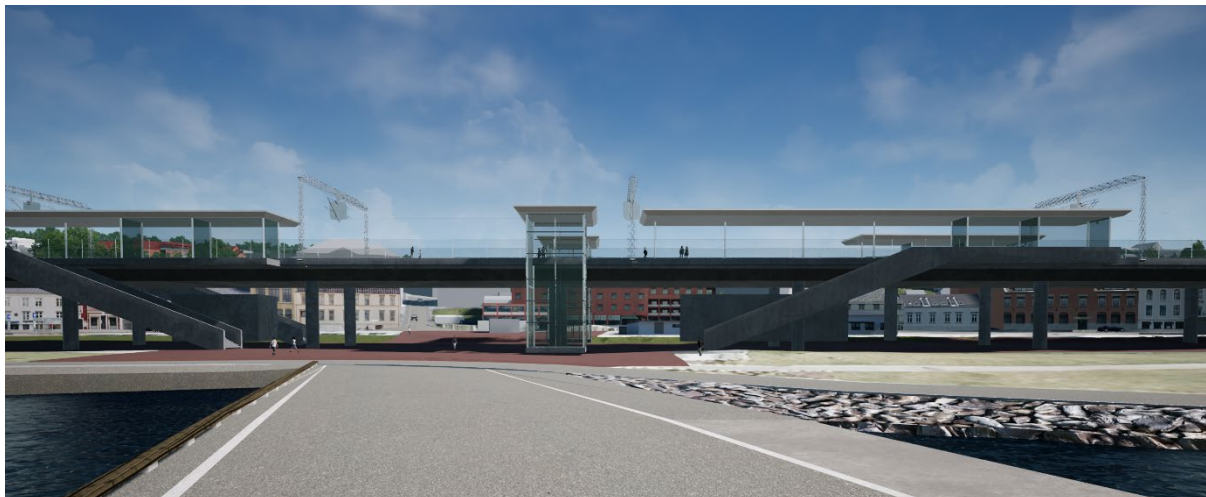
Figur 4-4 Larvik stasjon Indre havn høy sett fra fjorden. Bildet viser heistårn, trapper og plattformer. Eksisterende bebyggelse i bakkant. Retning Oslo til høyre i bildet
