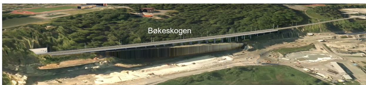
Figur 3-5 Bergeløkkalinja på bru i trasé for gammel E18 forbi Bøkeskogen. Bergeløkka til høyre i bildet
