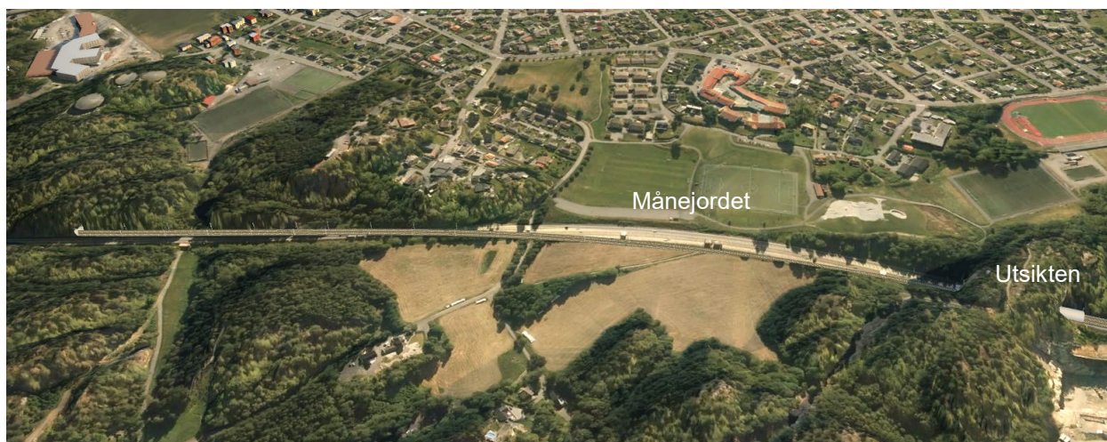
Figur 3-4 Forbi Månejordet har Bergeløkkalinja en ca. 1 km lang dagstrekning fram til gammel E18-tunnel under Utsikten. Retning mot Bergeløkka til høyre i bildet.
