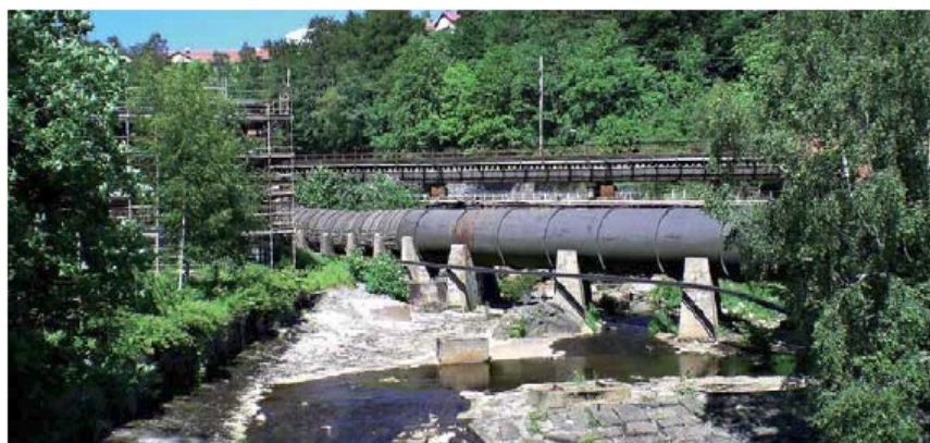
Figur 3-45 Rørgate 2 og jernbanespor over Farriselva. Kilde: NIKU Rapport28, 2007.
