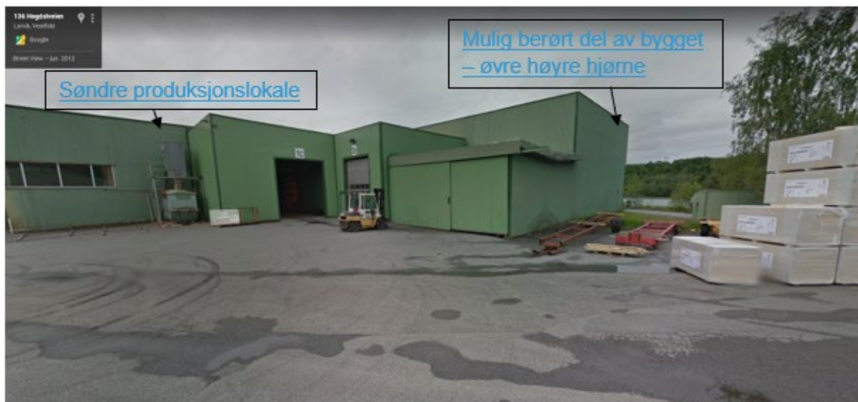
Figur 1-3, bilde av Hegdalveien 139. Pil til høyre i bildet viser hvilket hjørne av bygningen som vil kunne bli berørt av brua som vil passere over.
