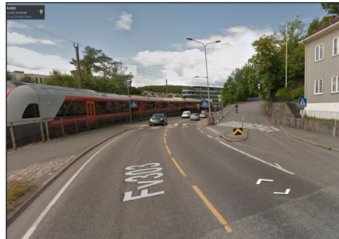
Figur 4-7 Krysset Bøkkerveien x FV 303 Storgata har en utforming som ikke tillater sving til/fra vest mot Storgata.
