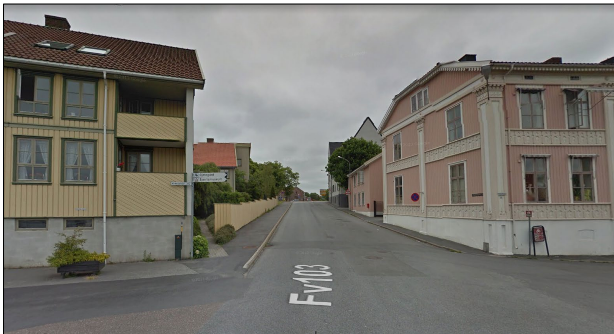
Figur 5-2 Bilde fra google som viser Strandpromenaden mot rundkjøring.
