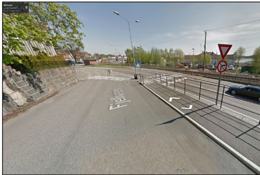
Figur 4-7 Krysset Bøkkerveien x FV 303 Storgata har en utforming som ikke tillater sving til/fra vest mot Storgata.
