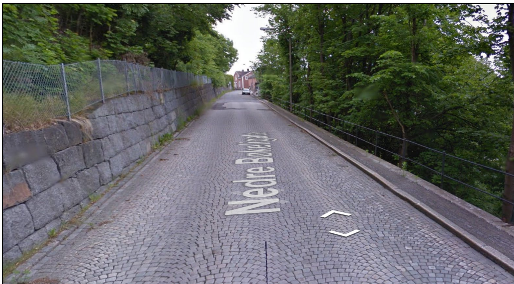
Figur 4-5 Nedre del av Nedre Bøkeligate med brosteinsbelegning og smal bankett inn mot rekkverk.
