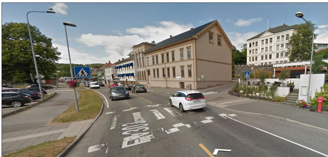
Figur 4-20 Kryss mellom Fv. 303 Storgata og Romberggata med opphøyd gangfelt over Storgata i forgrunnen.
