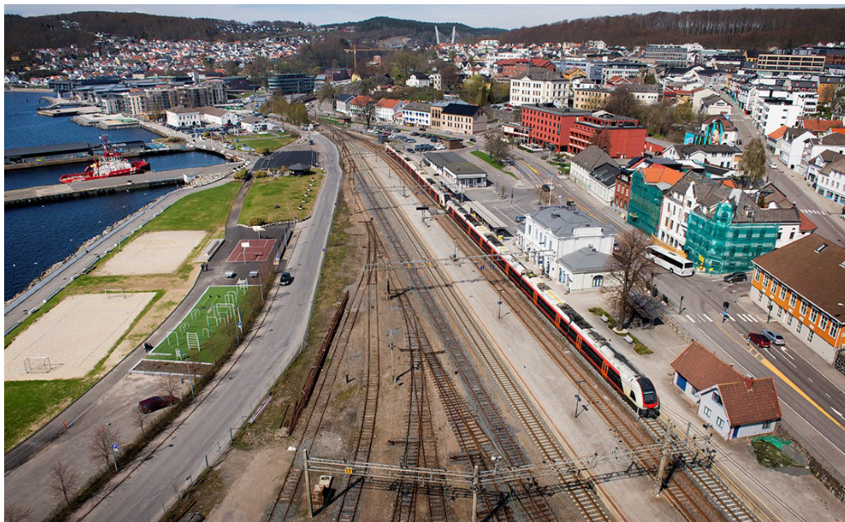
Indre havn er et av alternativene til lokalisering av ny jernbanestasjon som utredes av BaneNOR. Foto: Anne Mette Storvik, BaneNOR.
