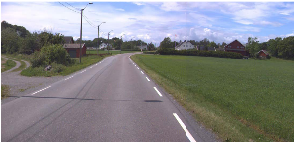
Figur 16, Eksisterende strømledninger. Kilde: Statens vegvesen
