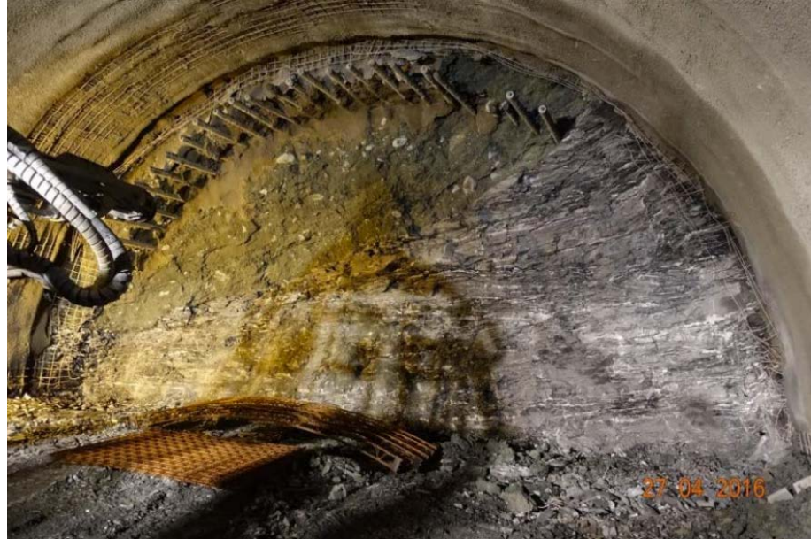
Bildet viser boring av rørskjerm ved Joberg løsmassetunnel
