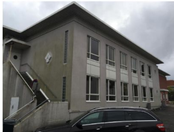
Figur 10. Nordøst- og nordvest-fasade til 2000-tilbygget. Foto tatt under befaring 2022-10-26.
