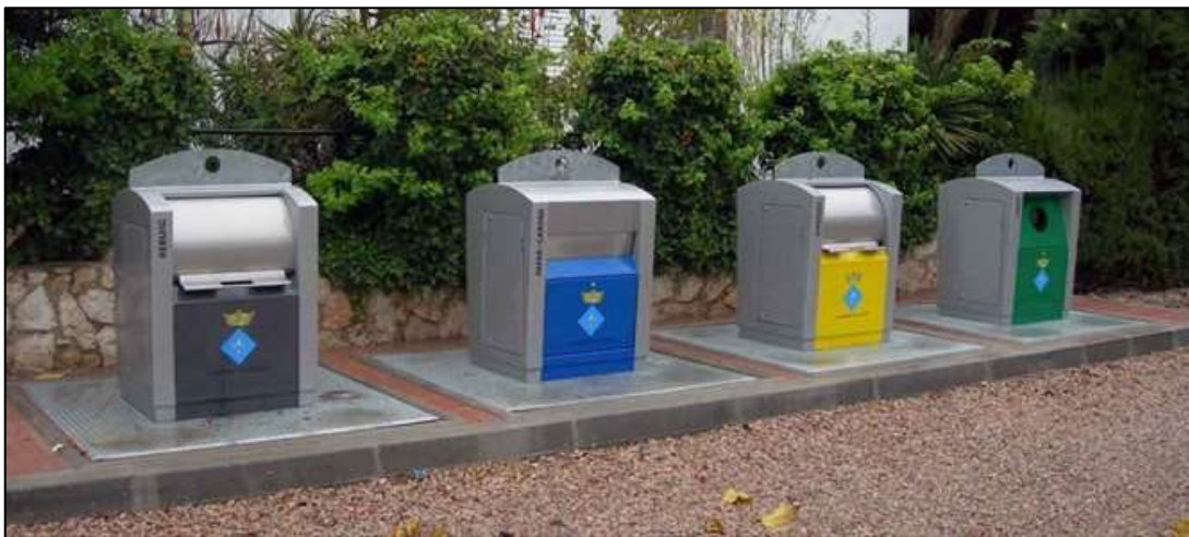
Figur 3-4: Helt nedgravd containerløsning for 4 avfallstyper
