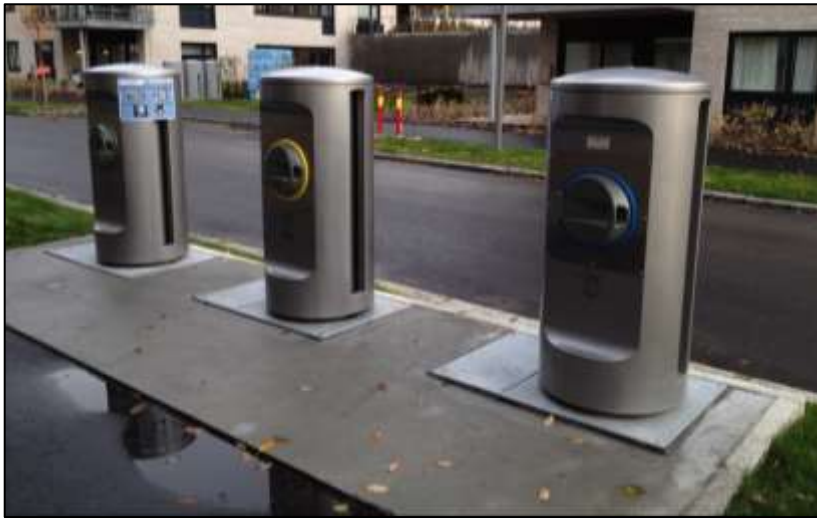
Figur 3-5: Nedkast til stasjonært avfallssug – 3 avfallstyper
