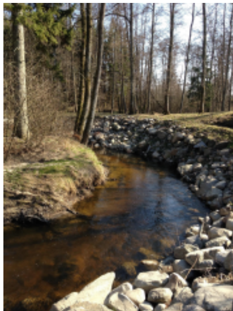
Steinsetting av elvekant for å hindre erosjon. Foto: Johanne Dolven.
