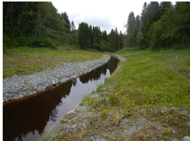
Figur 6.4 Motfylling og hevet bekkébunn i Klæbu i Trøndelag. Foto: Geir B. Hagen, NVE
