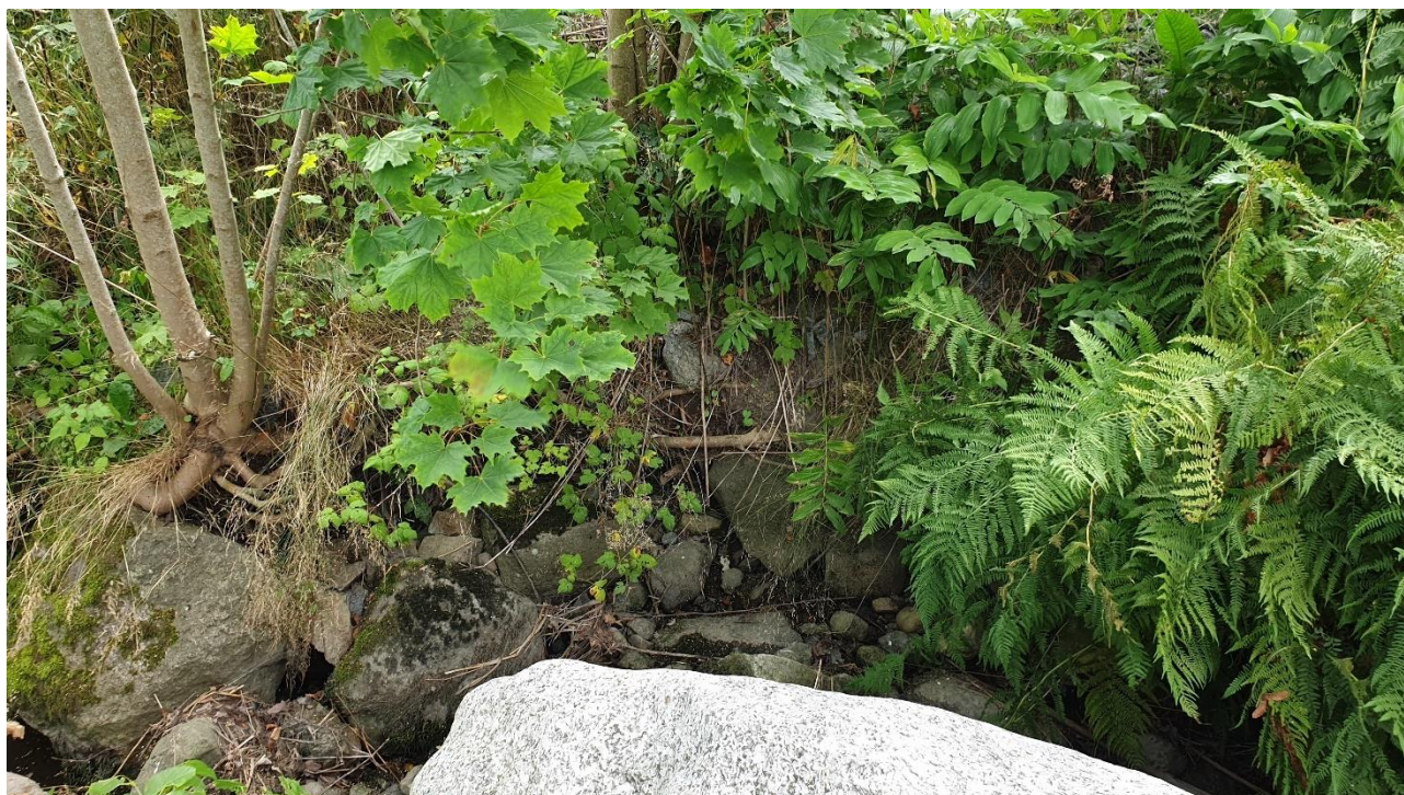
Figur 23 Parti mellom kulverter oppstrøms Stavernveien.
