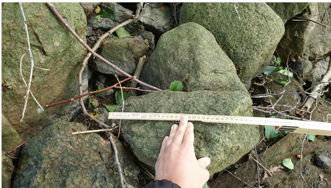
Figur 21 Typisk stabil stein ved yttersving oppstrøms Støperiveien.
