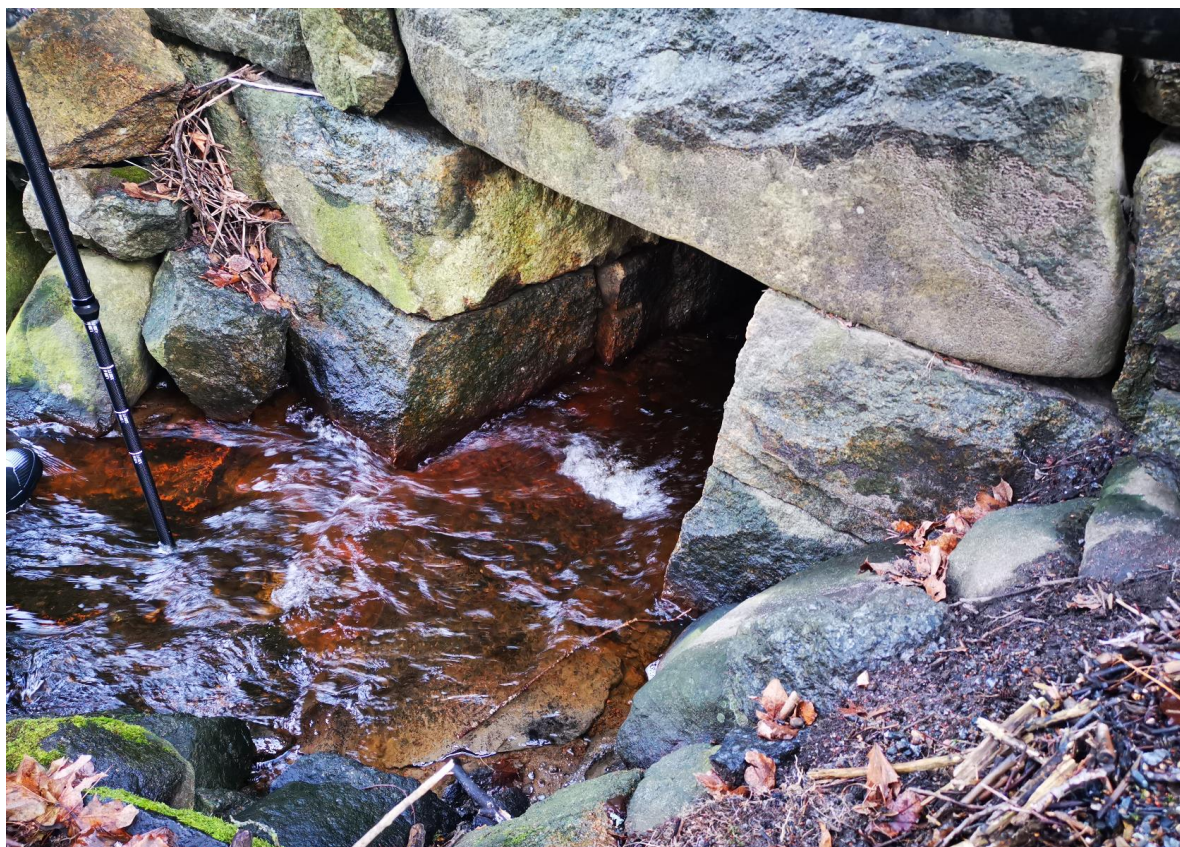
Figur 3 Tidligere kulvertinnløp under Gamle Stavernsvei
