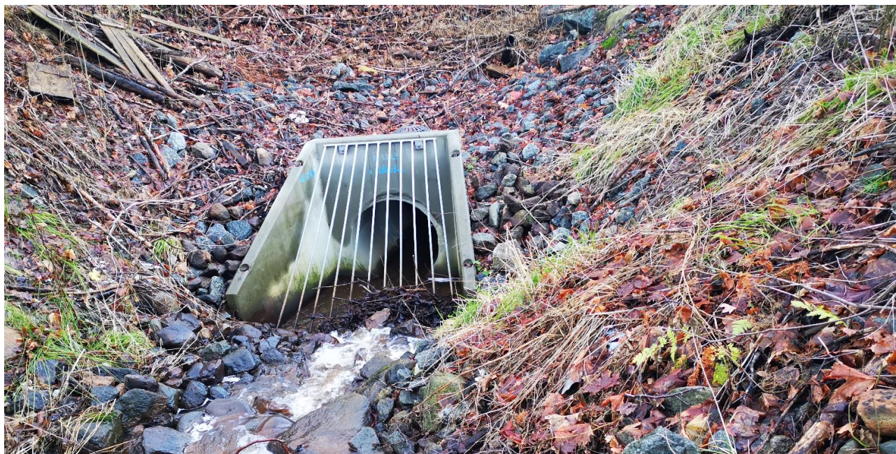
Figur 10 Inntak til kulvert under Holmejordetveien
