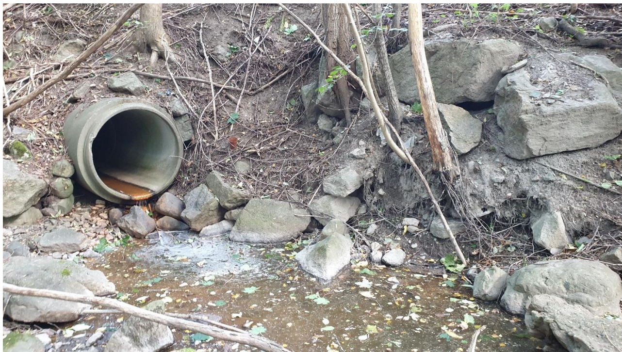
Figur 22 Utløp kulvert under Stavernveien.
