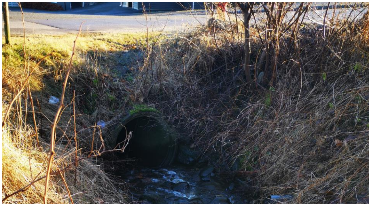
Figur 15 Kulvertinnløp under Støperiveien
