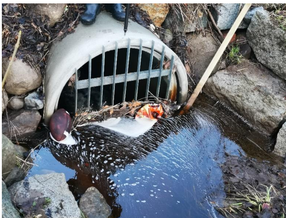
Figur 4-2. Kulvert på oversiden av Stavernveien. Foto: Sweco
