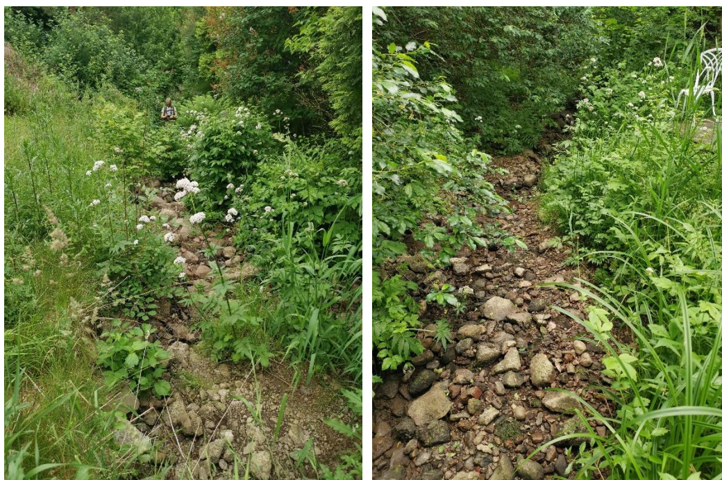
Figur 3-5. Tørrlagt strekning mellom Støperiveien 19 og Mørveien 43. Det ble tross utfyllingen funnet sjørørret ovenfor denne strekningen.
