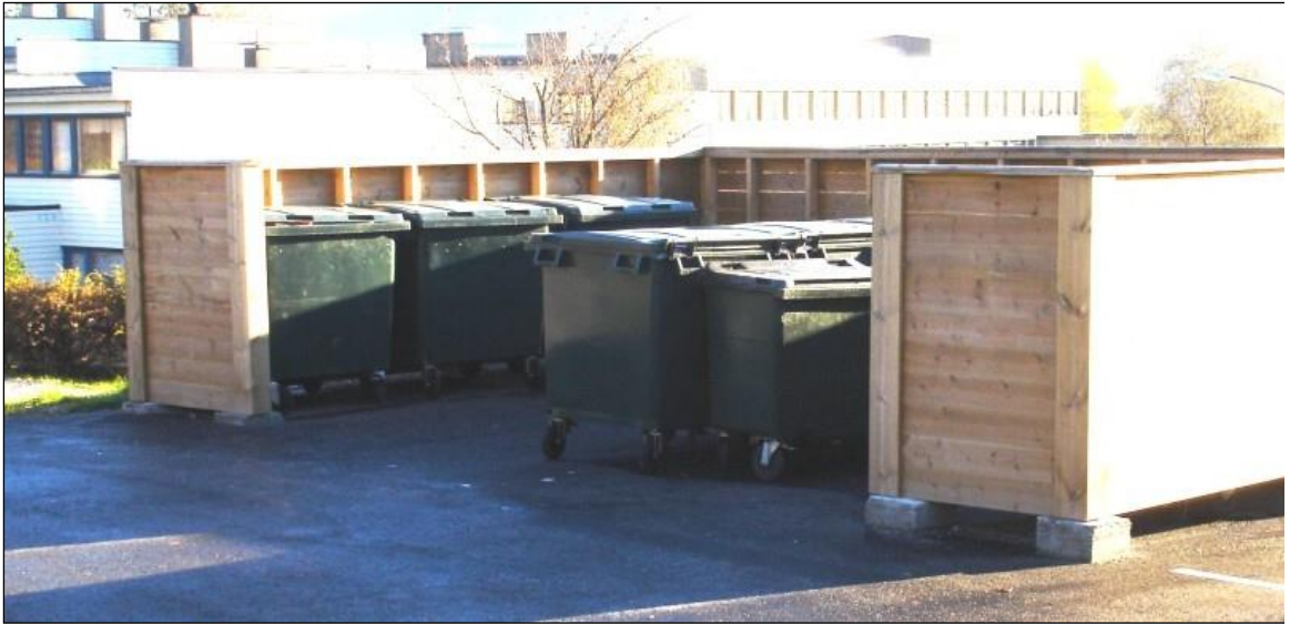
Figur 5-4: Oppsamlingsplass – skjermet med vegger.
