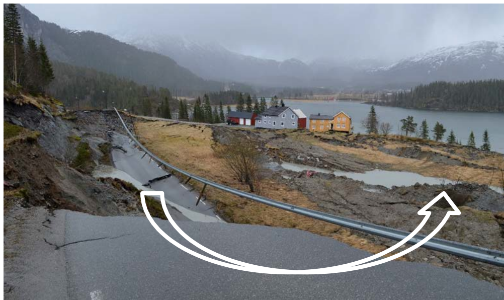
Figur 2.11: Rotasjonsskred i Tosbotn 2016. Foto: Fredrik Høgaas, NGU
