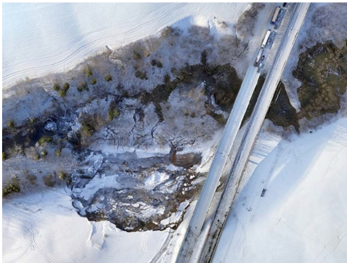
Figur 2.6 Skredet ved Skjeggstad bru på E18 i Vestfold utløst av fyllingsarbeider. Foto: Dronebilde, Orbiton
